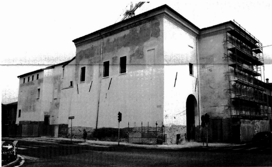
Il palazzo S. Sebastiano visto da Pusterla alla fine dei restauri (Foto 2000)
