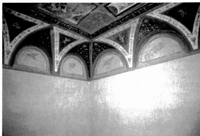
Due vedute del Camerino dei Falconi dopo il restauro
